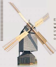
Eine frühe Form der Energiewende: Die drehbare **Bockwindmühle** kann komplett in jede Richtung gewendet werden und so die Windkraft optimal nutzen.
