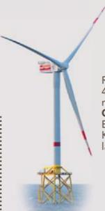
Rückenwind für Windkraft: 45 km nördlich von Borkum nimmt Deutschlands erster **Offshore-Windpark** den Betrieb auf. Faserverstärkte Kunststoffe machen die Anlagen stabiler und effizienter.
